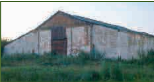
Село Бузівка. Колишня церква, нині складське приміщення. Фото 2016 року
